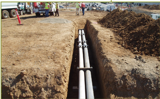
Conduits Installation in Elk Grove
